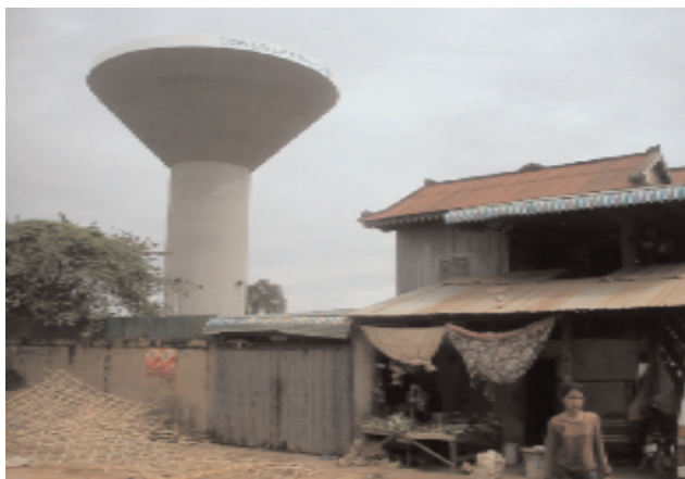
Château d'eau financé par l'AFD (© A. Blanc).
