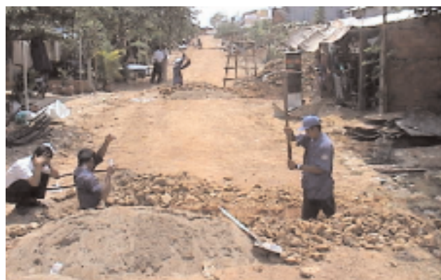
Travaux d'extension de réseau (© PPWSA).
