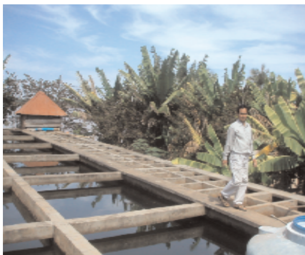
Station de traitement des eaux (© A. Blanc).
