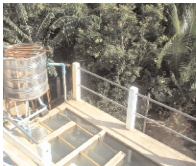
Station de traitement des eaux (© A. Blanc).
