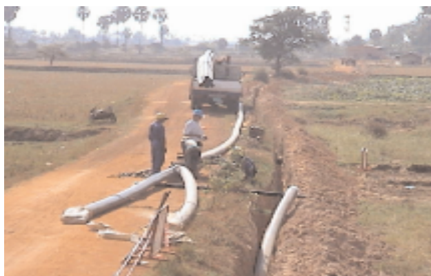
Travaux d'extension de réseau (© PPWSA).
