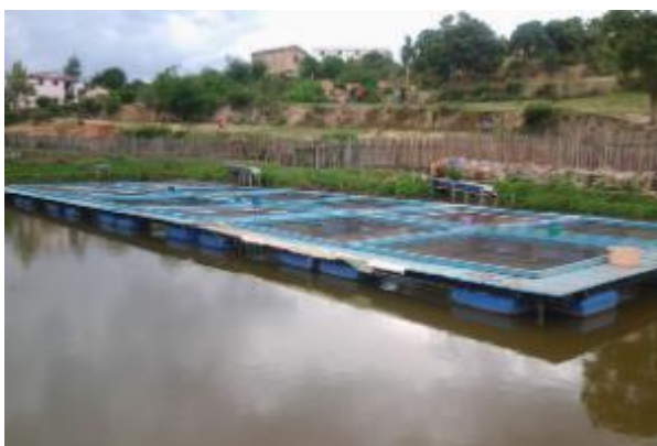
Illustration 2 : Pompage solaire de surface de 21kWc (Source : APB Energy)
