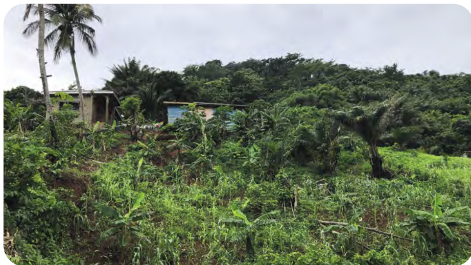
Figure 20. Exemples de zones de ruissellement et glissement de terrain
