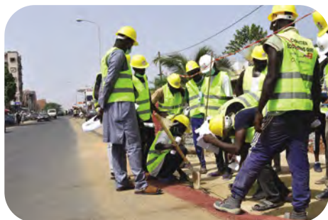
Figure 11. Pose de pavés drainants à Dakar
