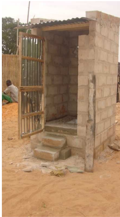
Latrine en construction au Sénégal (source : Eau Vive)
