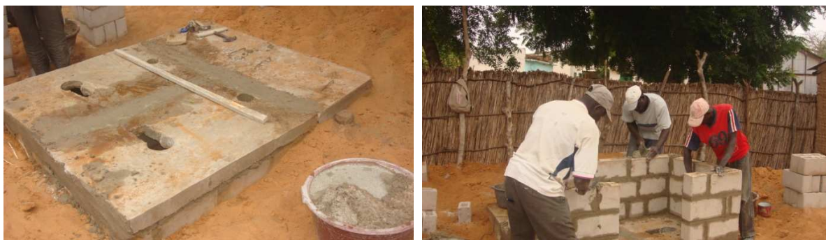
Formation de maçons à la construction de différents types de latrines à Ngogom (Sénégal) – source : Eau Vive.
