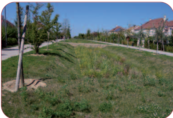
Exemple d'une noue engazonnée
