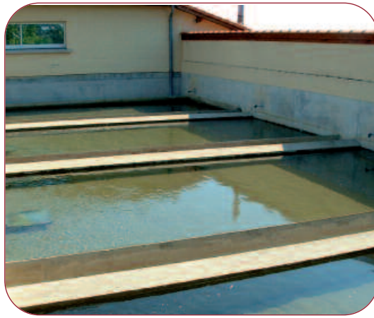
Filtres à sable dans une usine d'eau potable
