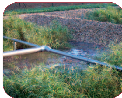
Surface d'un filtre planté de roseaux
