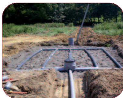
Filtre à sable pour ANC en cours de construction
