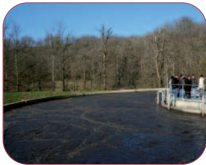
Bassin d'aération d'une station à boues activées contenant le floc bactérien en suspension
