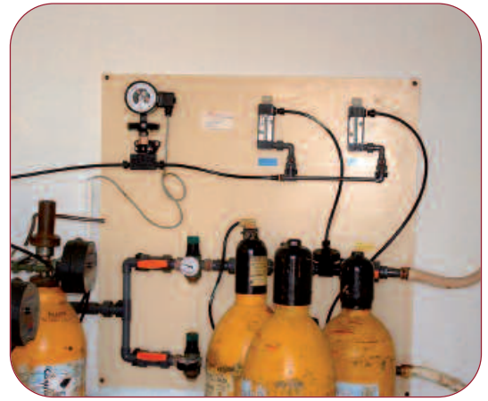
Système de chloration dans une usine d'eau potable
