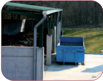
Stockage de boues de station d'épuration en attente d'épandage agricole
