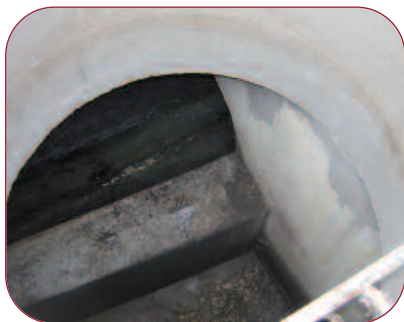
Un déversoir d'orage
