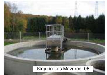
Le mélange est admis dans une jupe appelée Clifford. L'eau épurée est évacuée par surverse, les boues sont récupérées sur le radier où une pente est aménagée pour faciliter leur reprise. Une lame siphonide, contiguë à une lame crénelée de déversement évite le départ de flottants.
