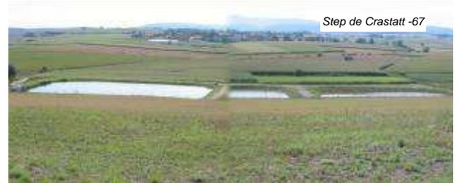
Il est préconisé de disposer de trois lagunes pour assurer un bon niveau de fiabilité du traitement. Si l'objectif de rejet comprend la désinfection, le nombre de lagunes peut être augmenté.
