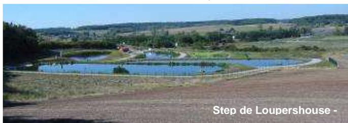
Le lagunage aéré se différencie des boues activées par l'absence de maintien d'une concentration fixée de micro-organismes (pas de recirculation). Cela conduit à prévoir des temps de séjour plus longs, plus favorables à une bonne adaptation du système aux variations de qualité de l'effluent à traiter. Ce procédé a un bon comportement vis-à-vis des effluents dilués ou si les débits ne sont pas bien équilibrés.
