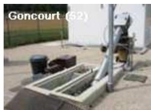
Peut être aménagé avec un système mécanique auquel on adjoint un compacteur ; cela limite les contraintes d'exploitation, réduit les nuisances et préserve la propreté.
