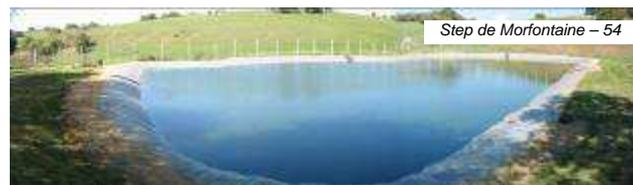
C'est le lieu de séparation physique des boues biologiques et de l'eau épurée. Cette lagune doit être régulièrement curée afin d'éviter les odeurs et la dégradation du traitement par les dépôts de boues.
