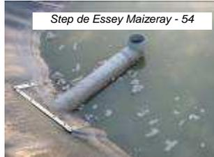
Il est nécessaire de prévoir un by-pass de chaque bassin pour faciliter les opérations de vidange et de curage et de disposer d'un trop-plein par bassin.
