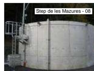
Il est conseillé d'adjoindre une agitation pour homogénéiser les boues si l'ouvrage a une capacité supérieure à 100 m<sup>3</sup>.
