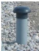
Prévoir un trop plein de 20 à 30 cm au-dessus de la surface d'infiltration pour l'évacuation de la charge hydraulique en cas d'un éventuel colmatage du massif.
