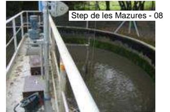
Si l'aération est effectuée par insufflation d'air (apport réel d'oxygène plus élevé au kWh que la turbine), la hauteur minimale est de 3 mètres. Il est préconisé 4 à 6 mètres pour améliorer le transfert d'oxygène et limiter les coûts énergétiques.
