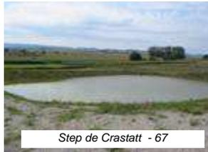
Il faut effectuer rapidement la mise en eau des ouvrages pour pérenniser la perméabilité (empêcher le risque de fissures et de développement de la végétation dans le sol), vérifier l'étanchéité et favoriser la mise en place de l'écosystème.
