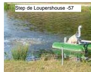
Pour limiter les dépôts qui peuvent perturber le traitement et pour prévenir la formation d'algues microscopiques, il est nécessaire de surdimensionner les aérateurs.
