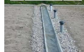
Pour éviter tout colmatage interne du massif, il est nécessaire de réguler le développement bactérien par alternance de l'alimentation des ouvrages. Cela est obtenu par des phases de repos pendant lesquelles les bactéries carencées sont réduites par prédation et dessiccation.
