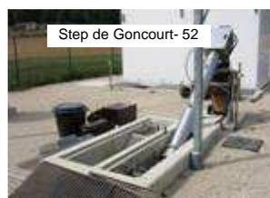
Peut être aussi aménagé avec un système mécanique auquel on adjoint un compacteur; cela limite les contraintes d'exploitation, réduit les nuisances et préserve la propreté.
