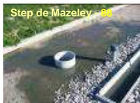
Cela évite l'immersion prolongée et les problèmes d'aération. Ce trop-plein doit être dirigé vers un système de traitement ou un bassin de stockage.
