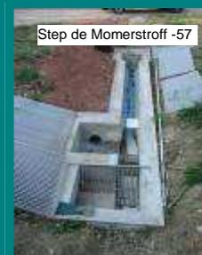
En présence d'un refoulement, avec débit de pompe calibré, la fonction déversoir sera supprimée. Avec un réseau séparatif, seul le canal de comptage sera conservé.
