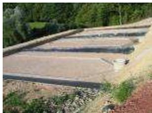
Le massif peut être constitué de plusieurs matériaux : du sable calibré dunaire, du sable de maçon, des alluvions (mais trop hétérogènes d'où existence de cheminements préférentiels) ou de la tourbe ou encore avec un matériau avec une forte surface spécifique (zéolithe).
