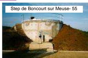
Il limite ainsi l'accumulation de dépôts dans les ouvrages et assure la stabilisation des boues primaires piégées et celle des boues biologiques en excès.
