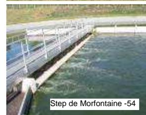
L'étanchéité de la lagune doit être effectuée par géomembrane pour limiter les risques de dégradation des berges dus au fort batillage de l'eau en mouvement.
