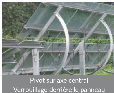
FIGURE 13 : PRINCIPAUX SYSTÈMES DE MODIFICATION D'AXE VERTICAL OU PLAN INCLINÉ (suivant l'heure)
