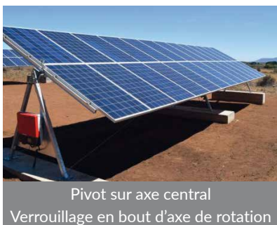
FIGURE 13 : PRINCIPAUX SYSTÈMES DE MODIFICATION D'AXE VERTICAL OU PLAN INCLINÉ (suivant l'heure)
