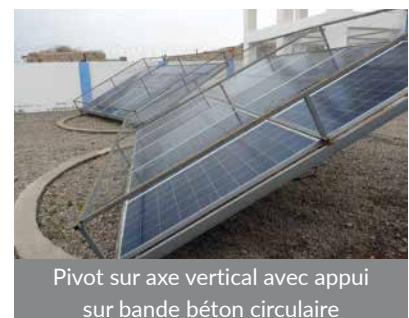
FIGURE 13 : PRINCIPAUX SYSTÈMES DE MODIFICATION D'AXE VERTICAL OU PLAN INCLINÉ (suivant l'heure)
