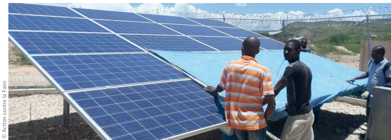
Test de couverture partielle des panneaux avec une bâche pour vérifier que la pompe adapte sa puissance en fonction de la puissance lumineuse reçue.
