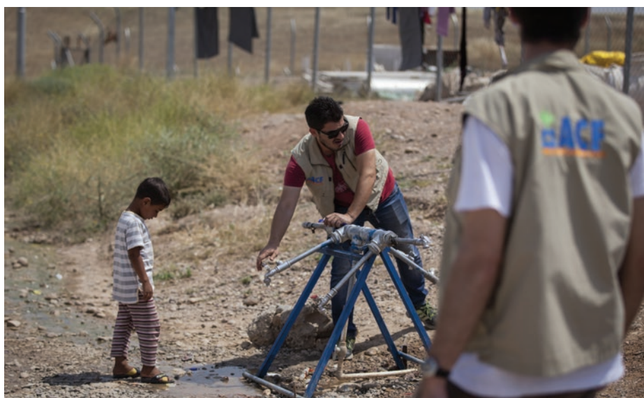
Photo: © Florian Seriex. Des techniciens dans le domaine de l'eau et l'assainissement vérifient les infrastructures hydrauliques dans le camp de Darashakran
