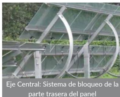
Eje Central: Sistema de bloqueo de la parte trasera del panel
