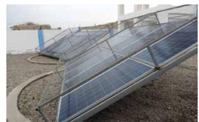
Eje desplazado con soporte en tira circular de hormigón
