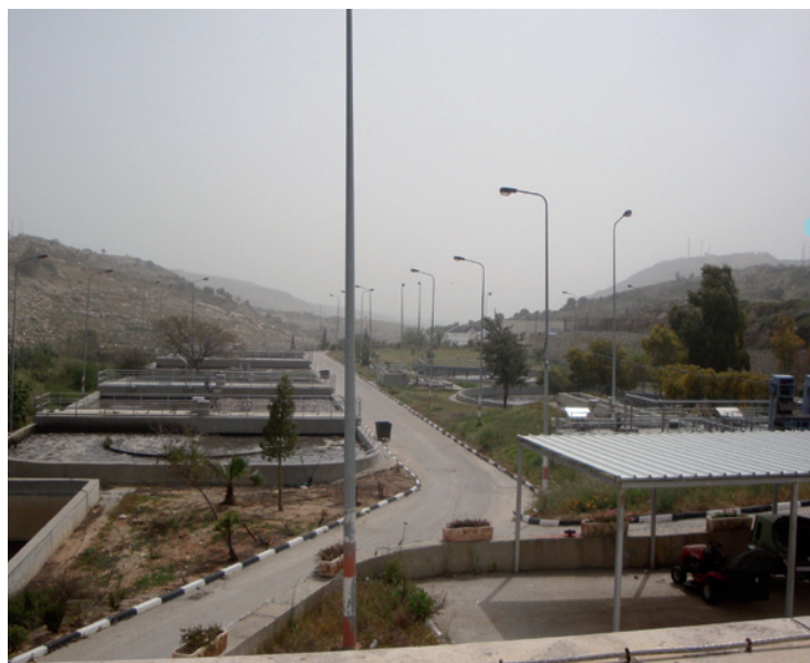
STATION D'AL BIREH 40 000 EH PRÈS DE RAMALLAH
