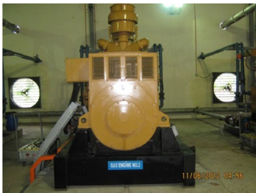
Photo 4 : Générateur à gaz (Source : Tawau, Malaisie, 2012)
