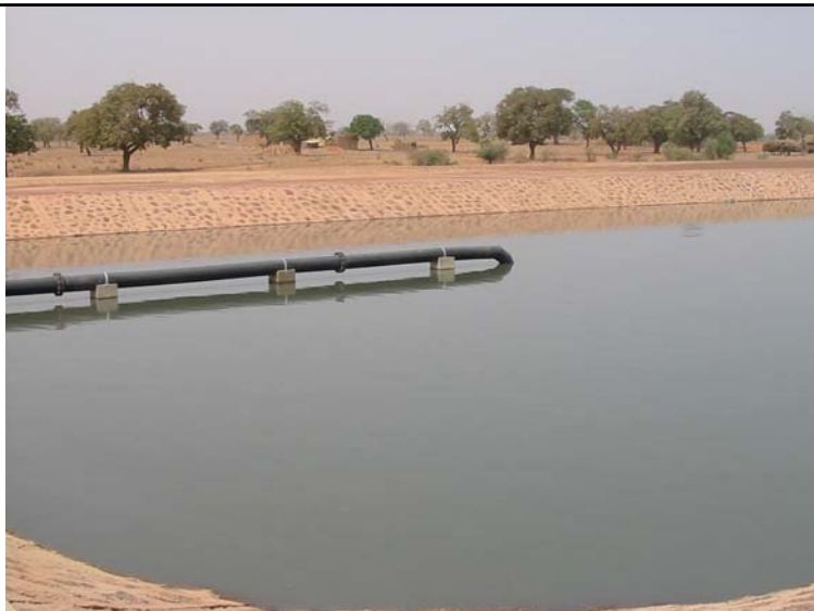
Ouagadougou : station d'épuration des eaux usées
