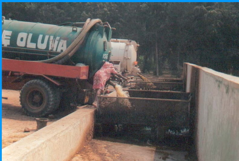
La station de dépotage et pré-traitement de SIBEAU (Cotonou)
