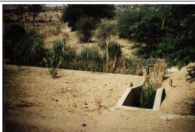
Espèces de tyha plantées pour assécher les effluents à l'exutoire et empêcher la réutilisation.
