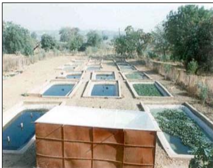
Station de lagunage mixte de Niamey
