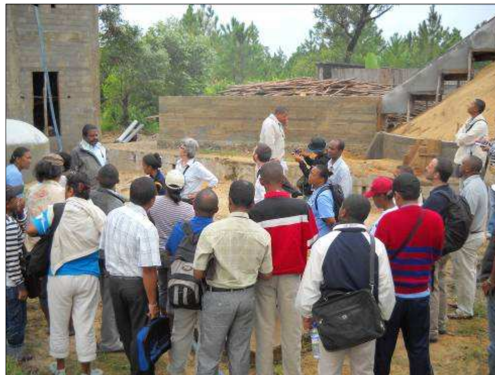
Réhabilitation du réseau d'eau potable et assainissement à l'entré du bourg de Foulpointe : Travaux en cours
