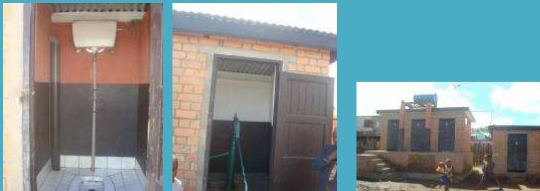
Photo n°6 : Infrastructure : Latrine collective en fosse septique en ferrociment (5m 3 )
