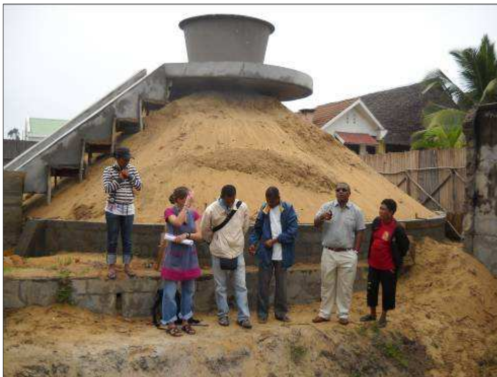
Réhabilitation du réseau d'eau potable et assainissement à l'entrée du bourg de Foulpointe : Le Maire de la Commune de Foulpointe expliquant le projet avec le Programme Meddea
