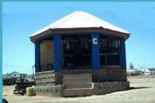
Etudes, réalisation des travaux et gestion du service eau et assainissement
