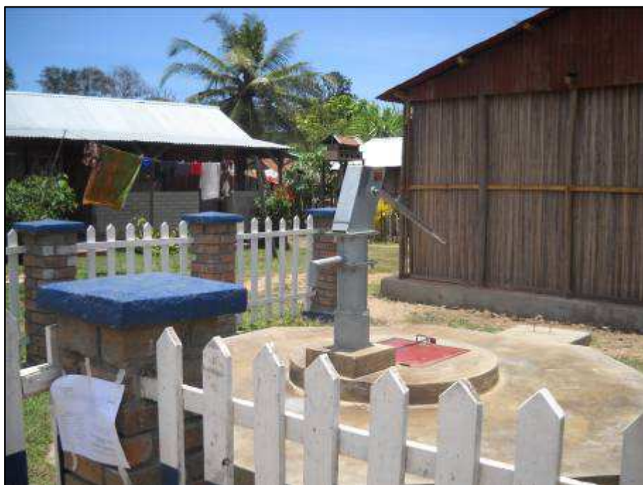
AEPMH dans le Fokontany Ambalavelona : équipée d'une pompe India Mark II, borne fontaine clôturée et bien entretenue, une fiche indiquant le règlement, les horaires d'ouverture et de fermeture de la BF, avec la liste des personnes responsables de l'entretien journalier est affichée devant le parc (cf. ci-dessus).
