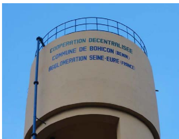
La cuve du château d'eau 1
