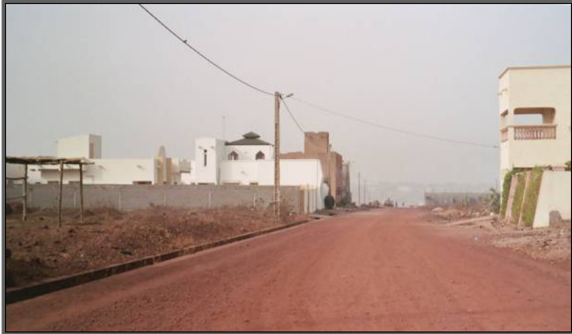
Image 3 : Voirie financée par le PDUD dans le quartier ACI 2000 à Bamako.
