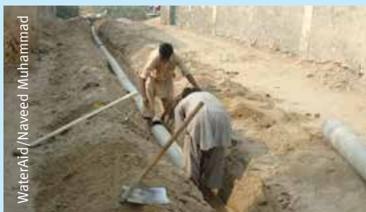
Installation des canalisations qui acheminent les eaux usées des latrines familiales vers les unités de traitement à Muzafagarh, au Pakistan.
