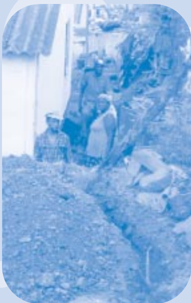
Participation de la main d'œuvre locale à la réalisation des travaux.
