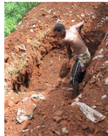
Creusage de la fosse d'enfouissement derrière le bloc d'Alakamisy
