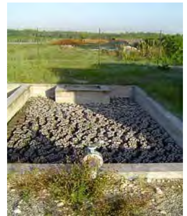
Aperçu d'un lit de séchage
