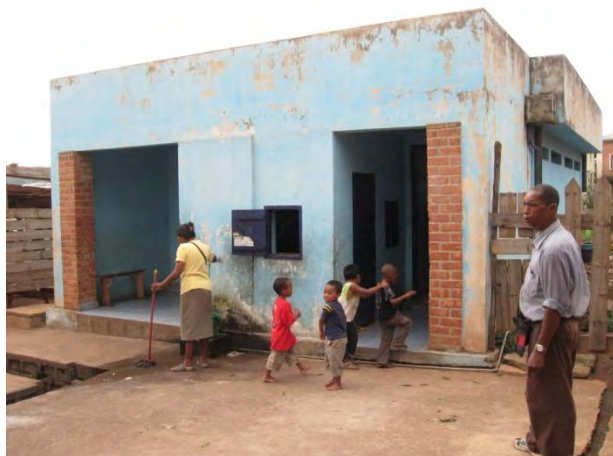
Bloc sanitaire d'Alakamisy
