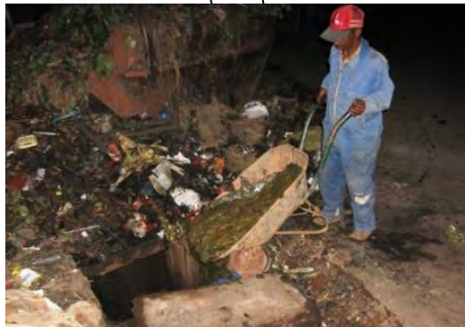
Déversement dans un regard ou dans la fouille d'enfouissement
