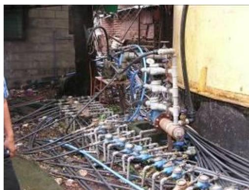
*Une installation défectueuse des compteurs produit des données peu précises et des erreurs de facturation. Dans la situation ci-dessus, les préposés à la lecture des compteurs peuvent difficilement déterminer quel compteur appartient à qui.*
