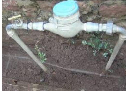
*Exemple de contournement illégal d'un compteur — une autre forme de vol et cause de pertes commerciales.*
