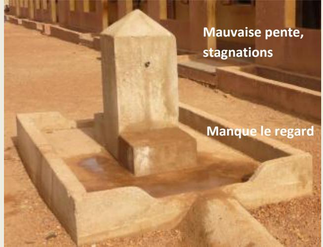
Puisard recouvert d'un regard avec poignée couchée, ou avec regard recouvert d'une fine chape
