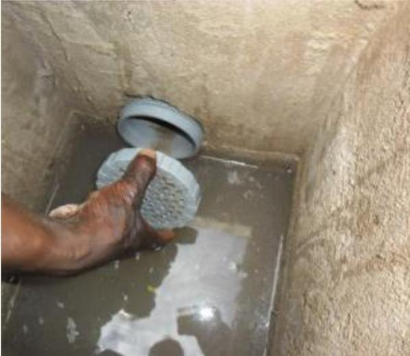
Dalle de couverture du regard encastrée et fermeture équipée d'une poignée couchée
