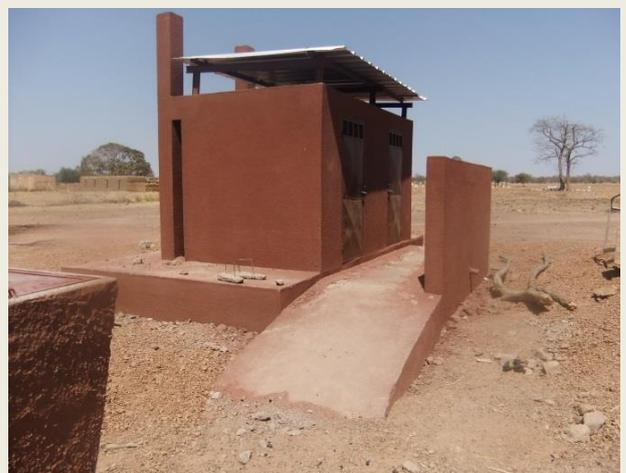
**Dalle SanPlat avec trou de défécation en forme de trou de serrure et repose-pieds. Pente de la dalle bien faite vers le trou de défécation.**
