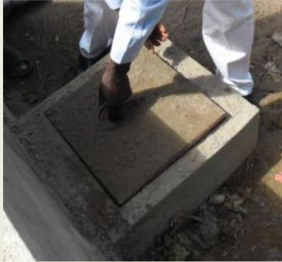
Plaque d'identification du forage en plastique très épais, recouverte par une couche de plâtrage, écriture faite par imprimerie et encre
