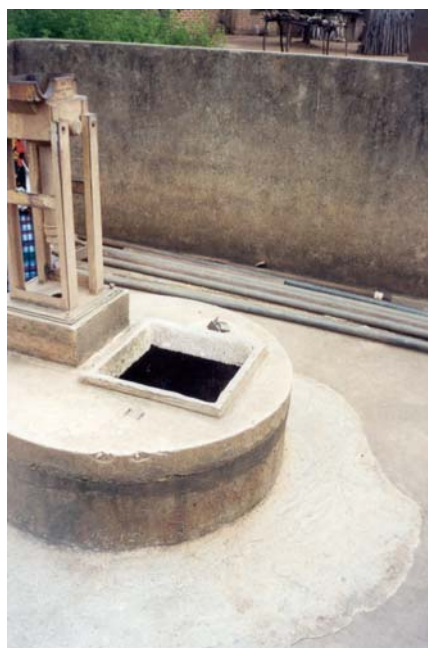
Exemple de puits moderne creusé mécaniquement dans les latérites du socle altéré à Korhogo (Nord, Zone 3)
