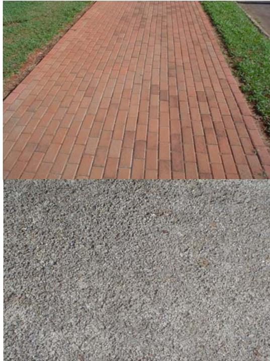
Figura 5.7 - Pavimento permeável do tipo concreto poroso
