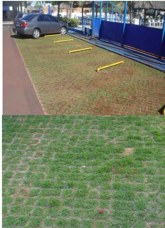
Figura 5.8 - Pavimento permeável do tipo bloco de concreto vazado
