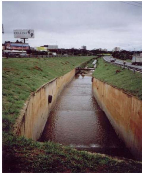
Figura 1.4 - Transição em concreto sob viaduto seguida por gabião - córrego Botafogo em Goiânia
