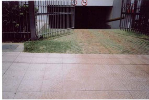
Figura 1.1 - Pavimento permeável - concregrama no Setor Bueno em Goiânia
