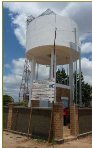
Le nouveau château d'eau et le local technique du comité de l'eau d'Anjozorobe (© pS-Eau)
