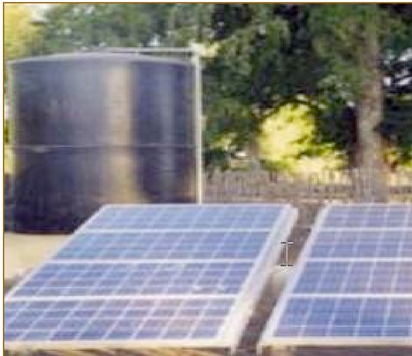
Panneaux solaires produisant l'énergie électrique pour le pompage et réservoir (© Fondem)
