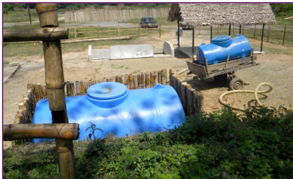
Lit de séchage solaire des boues et citerne de vieillissement (© Areed)
