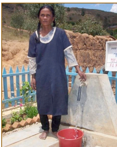
Borne-fontaine sur un réseau réhabilité par Girelpa (© Protos)
