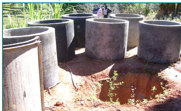
Réalisation sur place des buses pour équiper les puits, à Fianarantsoa (© Grand Lyon)
