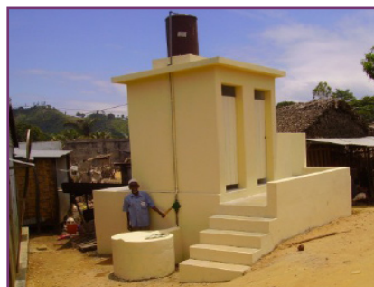
Modèle de latrine sur fosse septique (séparation parties sèches/liquides), avec système de chasse d'eau constituée d'une pompe à main (© Areed)
