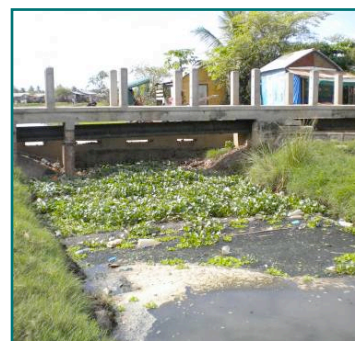
Jacinthes d'eau obstruant l'écoulement des eaux (© CG67)
