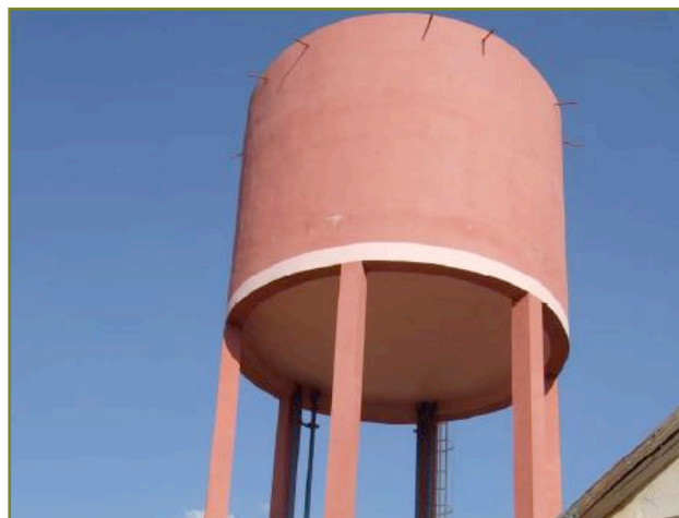
Le réservoir de 50 m 3 réalisé (© Sanea)
