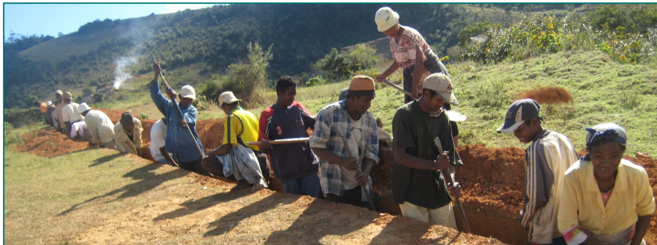
Réalisation des tranchées pour la pose des conduites à Alakamisy-Itenina (© Grand Lyon)
