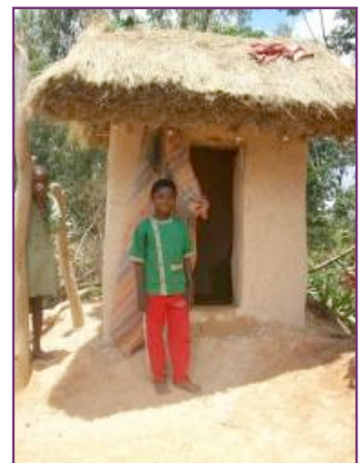
Latrine construite à Vinaninony
