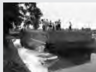
10. Station de traitement intensif décentralisée DEWATS
