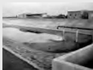
9. Bassin de lagunage
