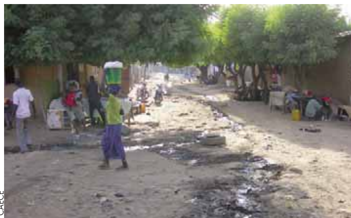
Zone du quartier Plateau avant les aménagements.
