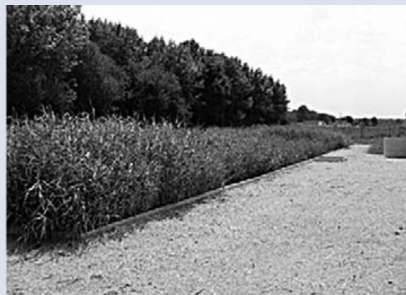
Vue d'une station d'épuration avec filtres plantés de roseaux.
