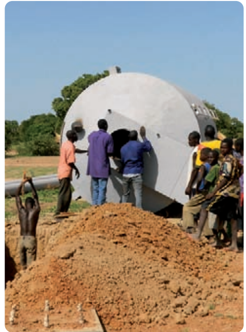
Implantation d'un château d'eau métallique
