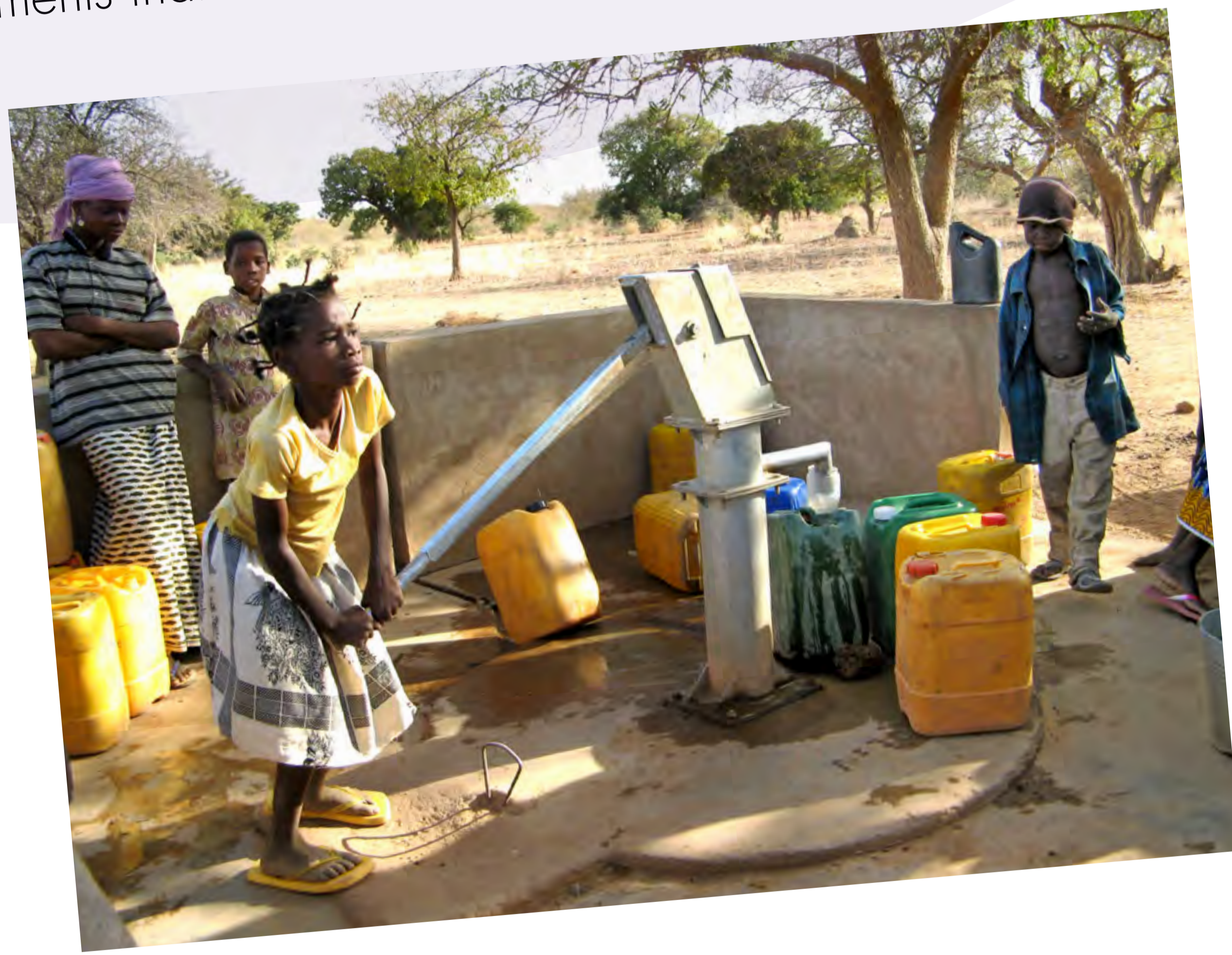
Forage équipé d'une pompe à motricité humaine, un exemple de point d'eau non motorisé au Sahel.
