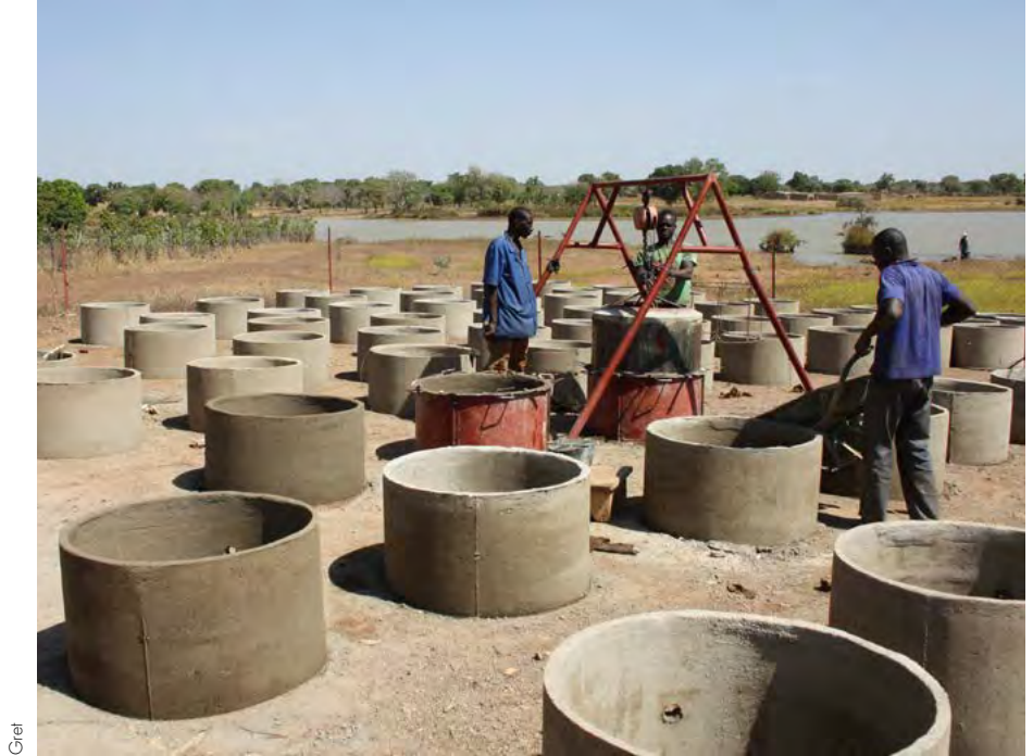
Site de production de toilettes d'un sanimarché au Burkina Faso
