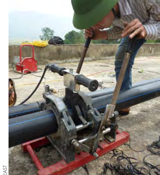
Soudure des tuyaux en PEHD
