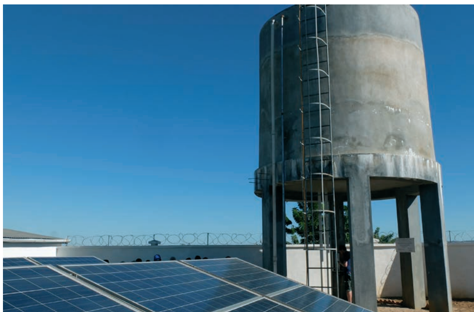
Château d'eau et pompage solaire à Madagascar
