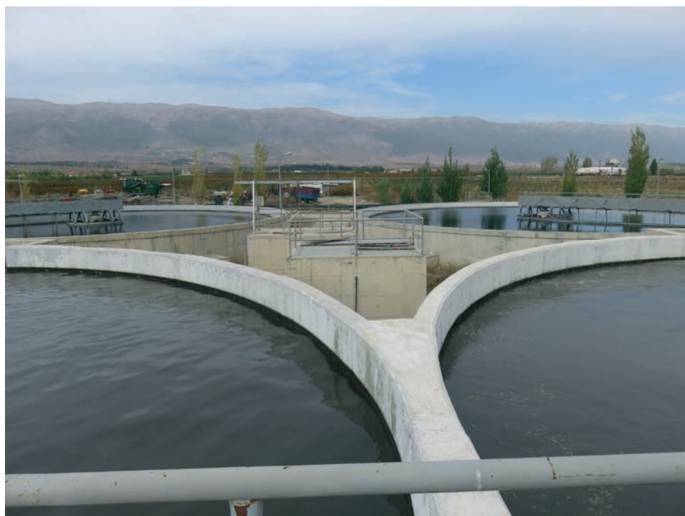
Station de traitement des eaux usées au Liban
