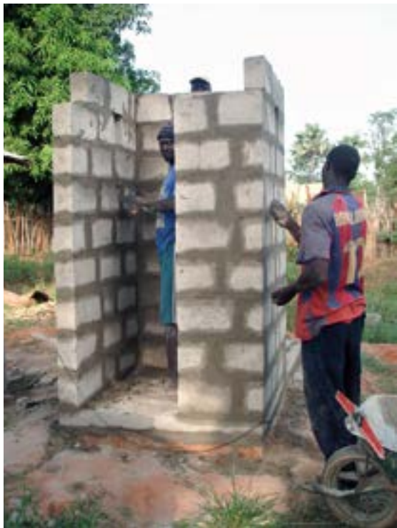
Latrine en construction dans la commune de Coubalan.
