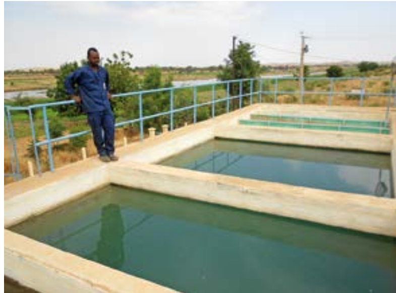
Station de potabilisation des eaux du fleuve Sénégal à Diawara.
