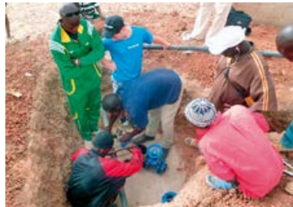
Chantier école supervisé par l'ADOS.
