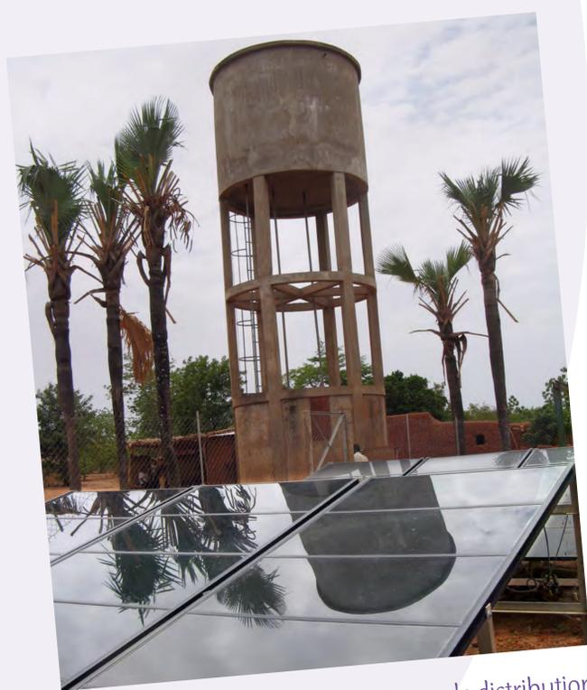
Château-d'eau alimentant un réseau de distribution grâce à l'énergie solaire
