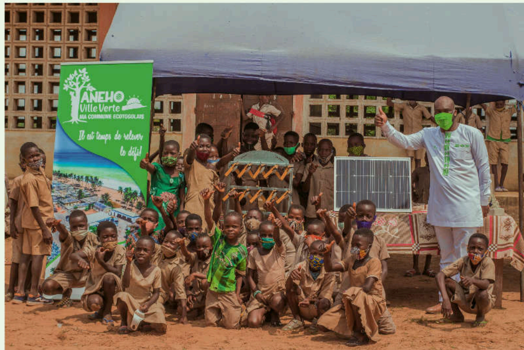
Installation de panneaux solaires et station de charge. Togo. ©Moi Jeu Tri
