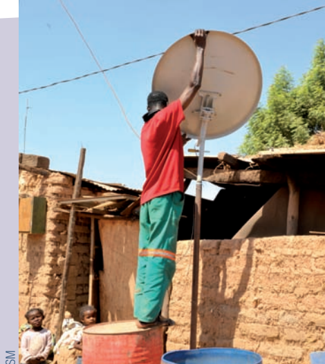
Installation d'antennes paraboliques
