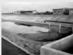
9. Bassin de lagunage
