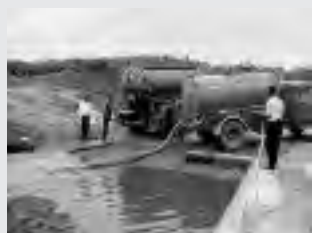
8. Site de dépôtage de boues de vidange
