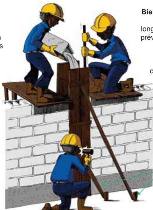
**Bien compacter** le béton avec une longue perche pour prévenir les poches d'air et frapper légèrement l'extérieur du coffrage avec un maillet de caoutchouc.
