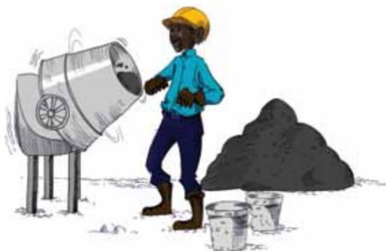
Pour les fondation en béton cyclopéen, verser le béton dans les tranchées à l'aide d'une brouette ou d'un dalot et placer les pierres préalablement mouillées au fur et à mesure dans la tranchée. Le béton ne doit jamais chuter d'une hauteur de plus de 90 cm.
