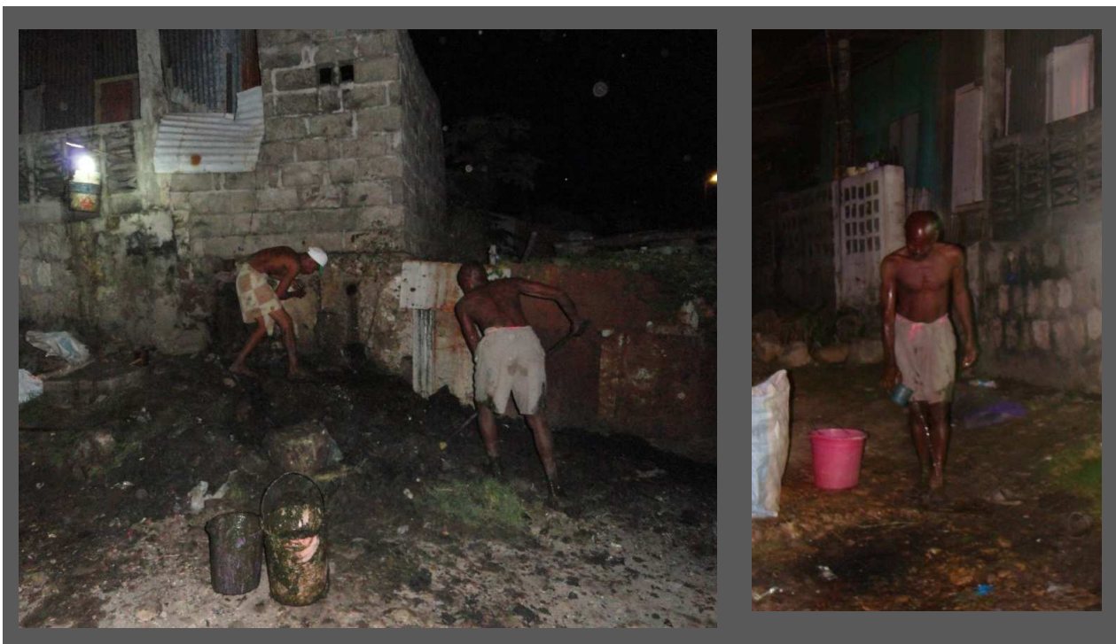
Figure 7 : Mode opératoire d'une vidange de latrine surélevée
