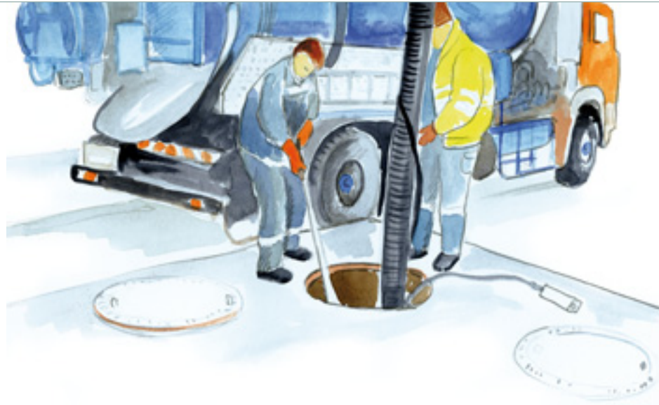
Figure 8. Opérations de nettoyage d'une bache par hydrocurage.
