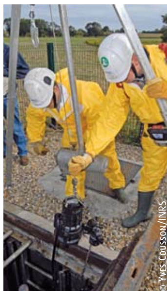
La manutention de charges (ici, une pompe à remplacer) s'effectue à l'aide d'un tripode muni d'un treuil.
