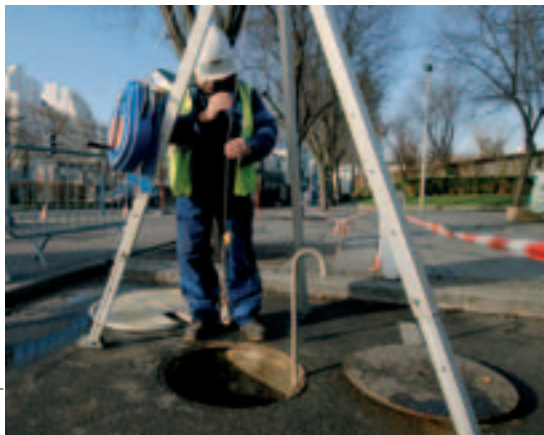
Contrôle d'atmosphère avant pénétration
