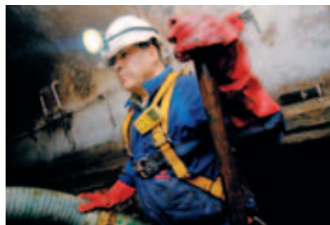
Contrôle d'atmosphère permanent avec détecteur individuel
