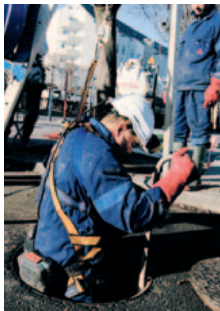
Sécurisation des entrées/sorties au moyen d'un système d'arrêt de chute
