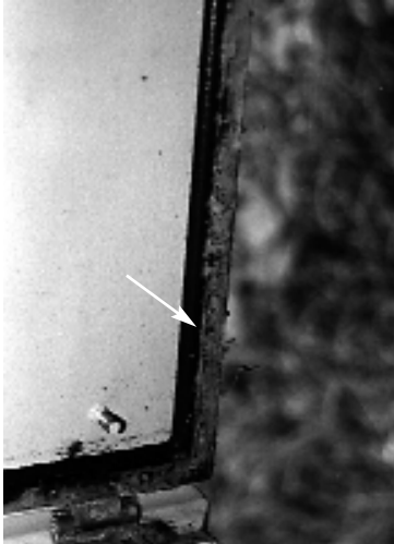
Photo 29: Joint en caoutchouc mangé par les insectes.
