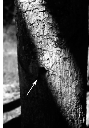
Photo 30: Support en bois des dépôts perforés par les insectes.
