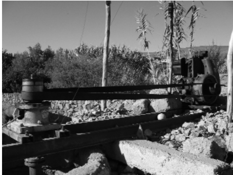
Photo 5. Pompe actionnée moyennant un moteur diesel au travers d'une courroie de transmission.
