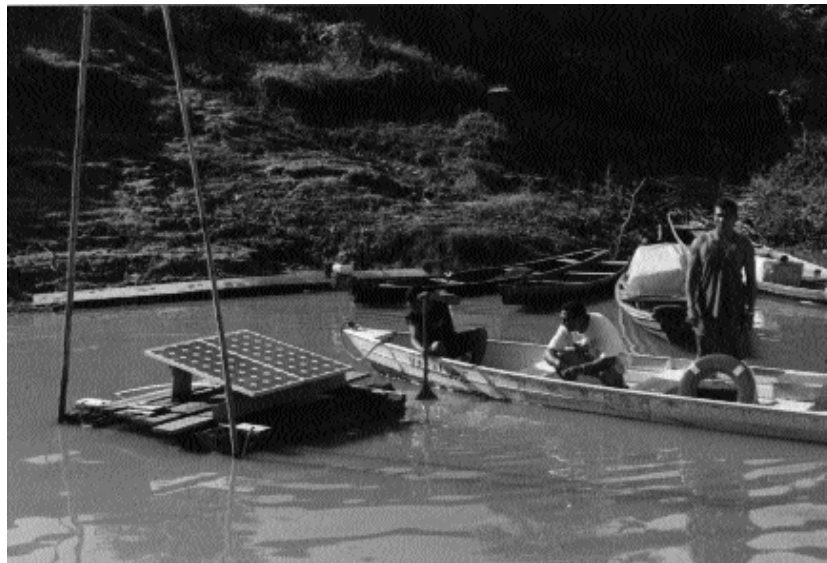
Photo 18. Système de pompage photovoltaïque de surface, installée sur une plateforme flottante.
