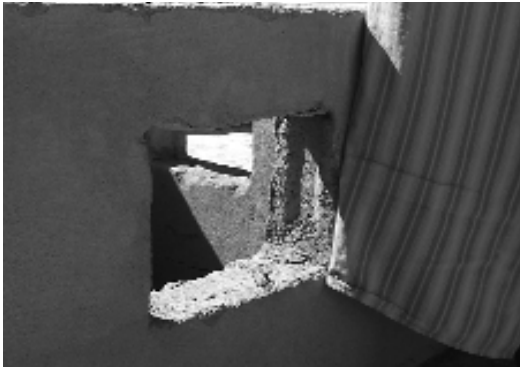
Photo 13. Dépôt d'eau avec les ventilations ouvertes avec des risques, comme on peut le remarquer, avec chute d'insectes.
