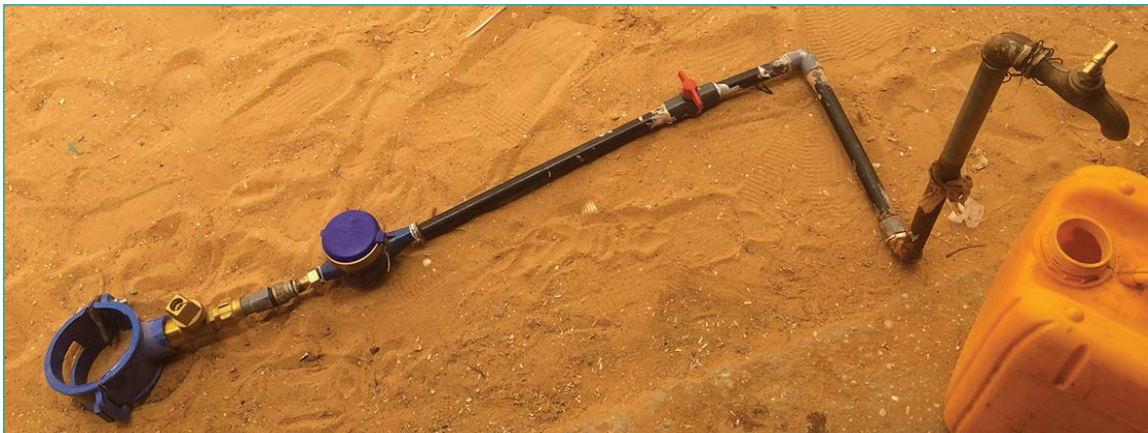
Montage standard d'un branchement
