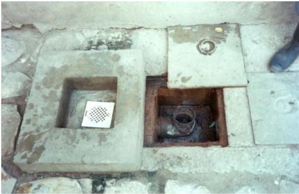
**Photo 17 :** Vidoir pour évacuer les eaux ménagères avec grille en plastique à Rufisque (Sénégal), suivi d'un bac dégraisseur.
