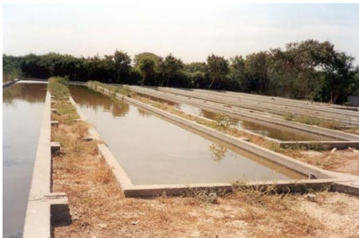
**Photo 2 :** Traitement des eaux usées par lagunage à Castor (Rufisque, Sénégal).
