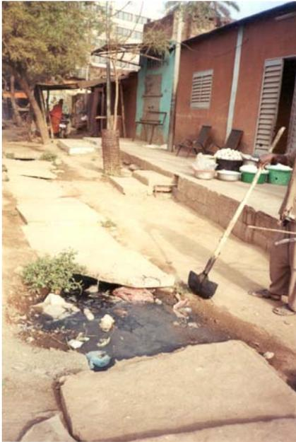
**Photo 6 :** Le caniveau bouché constitue l'exutoire d'un réseau à Bozola.
