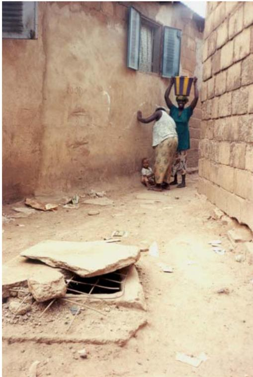
**Photo 7 :** Ruelle à Bozola avec la dalle de couverture cassée du regard du réseau.
