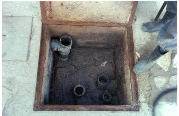
**Photo 18 :** Fosse de décantation à Rufisque (Sénégal) recevant les eaux vannes et ménagères (du vidoir).
