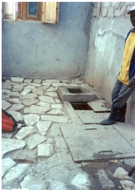
**Photo 2 :** Vidoir, deux bacs dégraisseur et la fosse de décantation à l'intérieur d'une concession à Rufisque (Sénégal).
