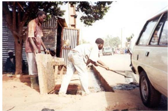
**Photo 9 :** Travaux d'entretien à Banconi. Il est à noter que le matériau enlevé est déposé in situ.
