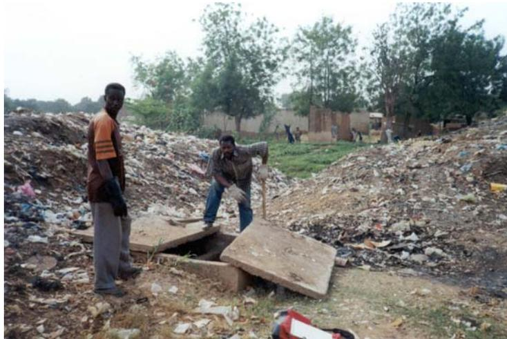
**Photo 10 :** La gestion des eaux usées et des ordures est étroitement liée. La photo montre un regard filtrant du réseau de Banconi au milieu des dépotoirs sauvages.
