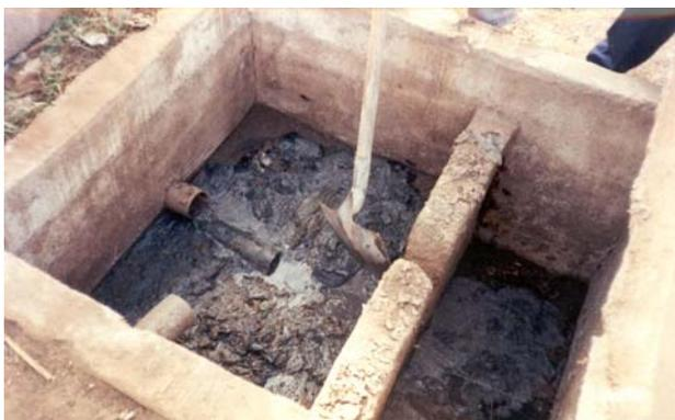
**Photo 11 :** Regard filtrant à Banconi. Le "filtre" à gauche est bouché et by-passé (voir fente dans la paroi intermédiaire).
