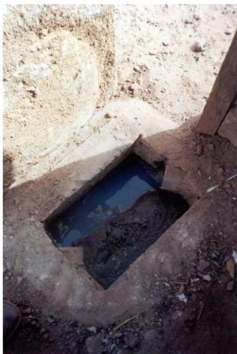
**Photo 5 :** Boîte de branchement à Banconi. Le dépôt de sable est bien visible.
