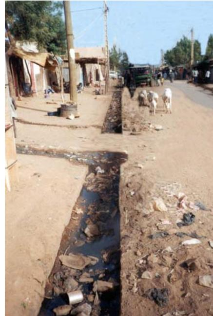
**Photo 14 :** Caniveau rempli d'ordures et d'eau polluée. A gauche, écoulement d'eau usée des habitations dans le caniveau.
