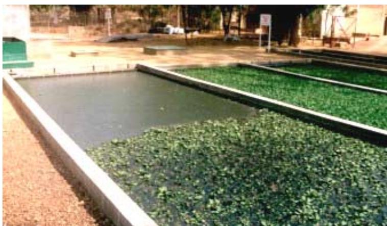
**Figure 7.4:** Remontée et accumulation de boues à la surface du premier bassin - dépérissement de *Pistia stratiotes* sous fortes charges organiques, (en premier plan laitue d'eau à la sortie du bassin).
