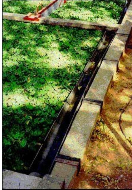
*Figure 3.7 : Gouttière de répartition à l'entrée du bassin*
