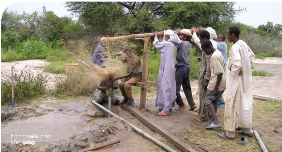
Forage manuel au lançage à l'eau (jetting)
