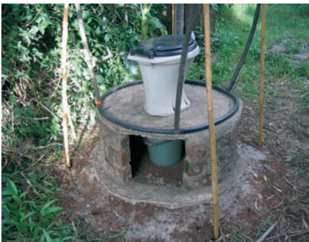
Photo 7-5 : Dalle et siège posés sur une base
