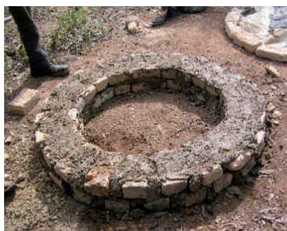
Photo 3-12 : Finalisation du soubassement en briques.
