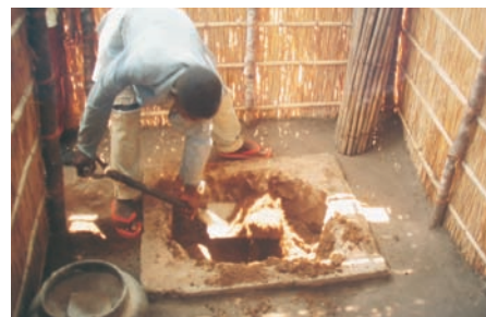
Photo 4-22 : Evacuation de l'humus de la fosse
