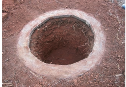
Photo 3-46 : Une fosse creusée à l'intérieur du soubassement.
