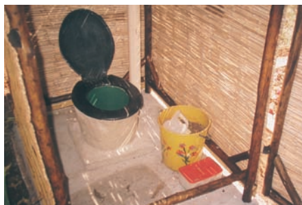
Photo 4-18 : L'intérieur d'une Fossa alterna équipée d'un siège
