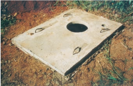
Photo 4-13 : Pose de la dalle de béton
