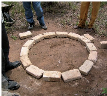
Photo 3-5 : Ceinture de briques pour le moule.
