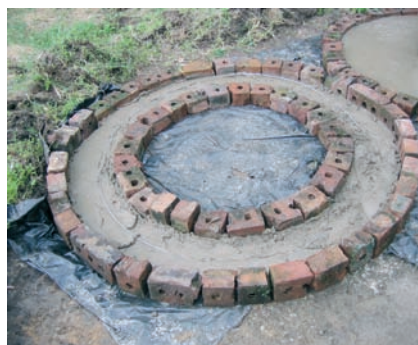
Photo 3-30 : Mélange de béton dans le moule
