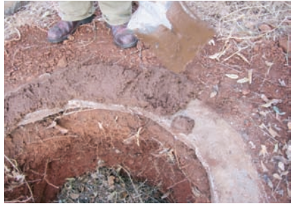
Photo 3-48 : Mortier étalé sur le soubassement.
