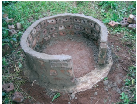
Photo 7-4 : Mur de brique bâti sur le soubassement
