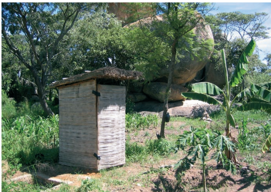
Photo 13-1 : Eco-latrine à Ruwa, au Zimbabwe
