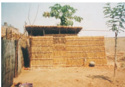
Photo 4-21 : Une Fossa alterna avec structure permanente
