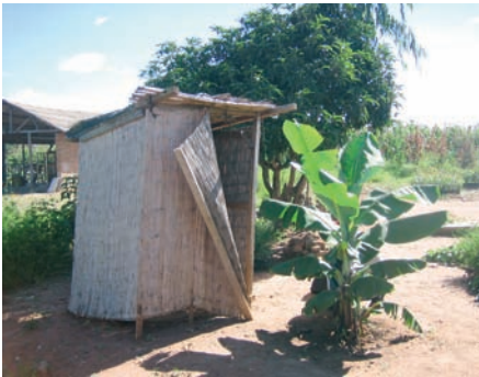
Photo 3-39 : Superstructure en matériaux locaux.
