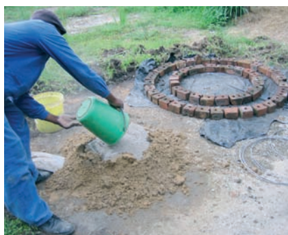
Photo 3-29 : Mélange de ciment et de sable mélange
