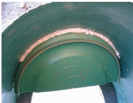
Photo 6-25 : Le séparateur d'urine est scellé aux parois du seau
