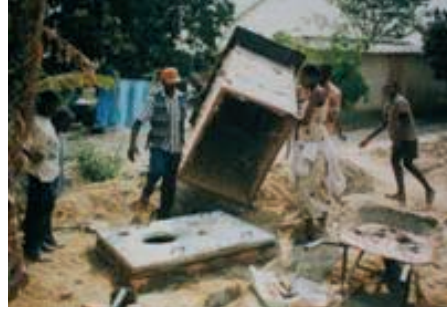
Photo 7-10 : La Fossa alterna construite sur une dalle rectangulaire
