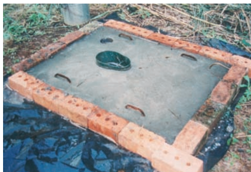
Photo 4-7 : La dalle finalisée à l'intérieur du moule.
