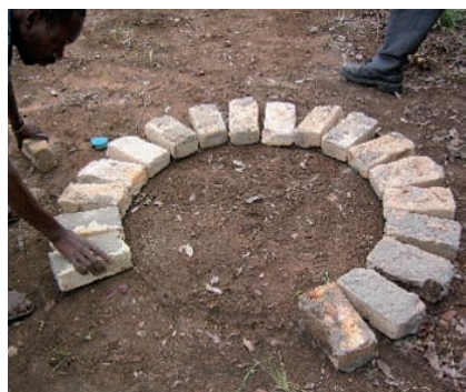
Photo 3-10 : Réalisation du soubassement en briques.
