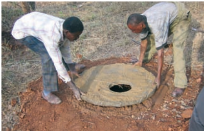
Photo 3-49 : Pose de la dalle sur le soubassement
