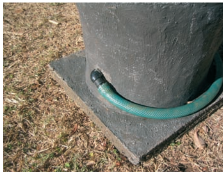
Photo 6-27 : Tuyau de canalisation de l'urine attaché.
