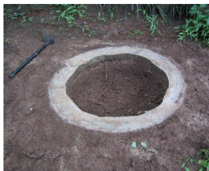
Photo 3-18 : Creusement du trou à l'intérieur du soubassement.
