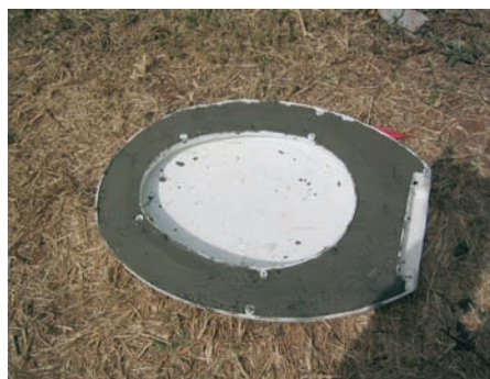
Photo 6-17 : Béton ajouté au siège de latrine
