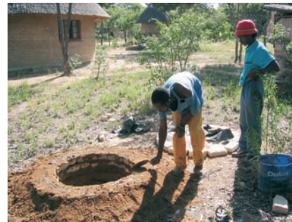
Photo : 3-34 : Elévation du niveau du sol autour du soubassement de briques
