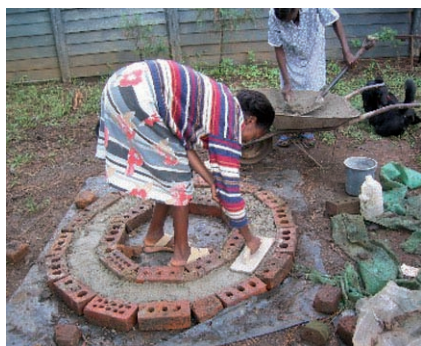
Photo 3-16 : Nivellement du béton.
