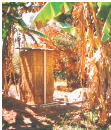
Photo 4-16 : La Fossa alterna avec des murs d'herbes
