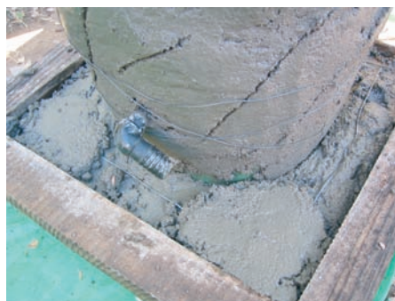
Photo 6-23 : Fil de fer supplémentaire pour le renforcement
