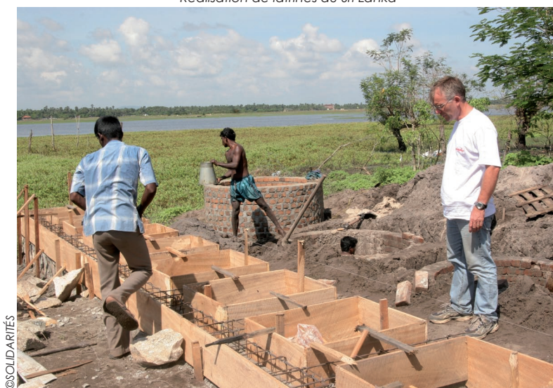
Réalisation de latrines au Sri Lanka
