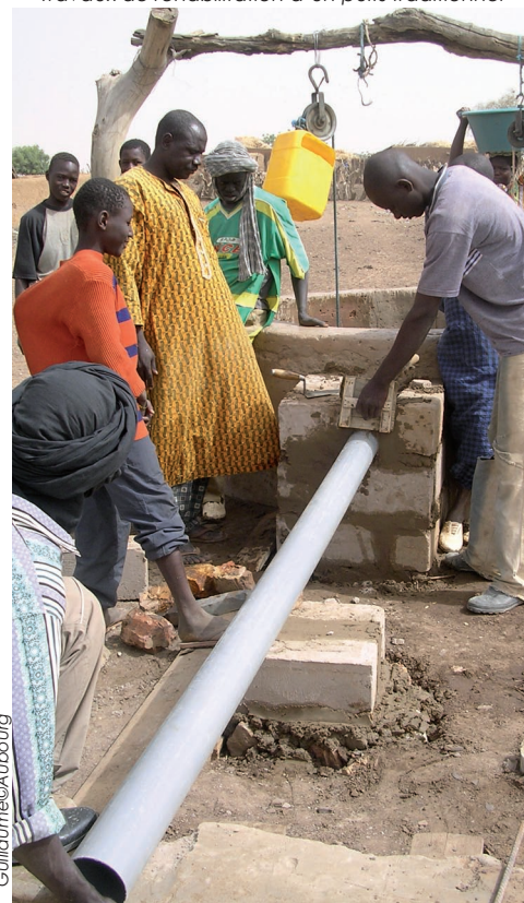
Travaux de réhabilitation d'un puits traditionnel
